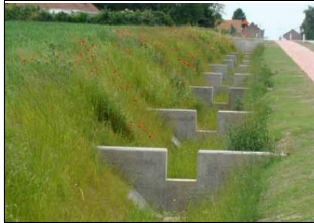
Figuur 89: Gracht met stuwconstructies (Bron: Vlaamse Overheid; [48])
