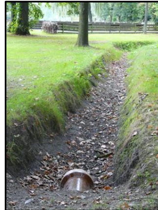
Figuur 85: Voorbeeld infiltratiegracht (Bron: Waterbewust bouwen; [45])
