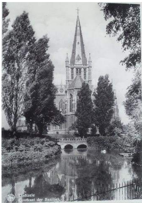
Fig. 18. Prentkaart verzonden 1 mei 1941. De oostkant van de OLV Basiliëk vanuit 't Torreke. De walgracht wordt begrensd door een ijzeren hekwerk (recent vervangen door nieuw metalen hekwerk). Bemerkt 4 (5) Italiaanse populieren.
