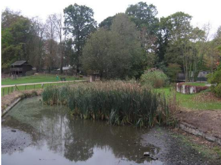
Foto. Zicht op het zuidelijk deel van de kasteelgracht die de voorbije jaren stilaan is dichtgegroeid met grote lisdodde (na droogvallen). Door het ongewoon lage waterpeil is de historische oeverbeschoeiing zichtbaar. Onderzoek naar de toestand ervan met het oog op duurzaam herstel of reconstructie is aangewezen alvorens tot het eventueel ruimen van de kasteelgracht over te gaan (foto 25 oktober 2018).
